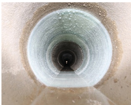
LV 2: Kurzliner, Anschlusskragen (Hutprofil), T-Stück | www.resinnovation.com
